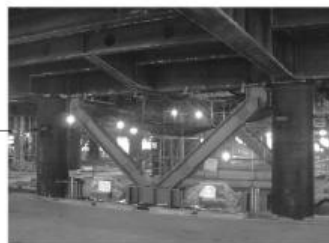
粘性系ダンパー 「セミアクティブオイルダンパー」 (356基設置)
