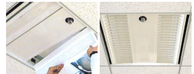
③ LEDユニットの取付
