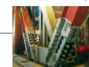
ブレイキ材の摩擦力により、揺れエネルギーを摩擦熱に変換し、建物の損傷を低減。
