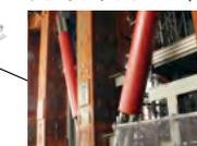
柔らかく粘りに優れた鋼材を使用したブレースで、大地震時のエネルギーを効果的に吸収。
