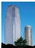
愛宕グリーン ヒルズ (MORIタワー)
